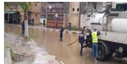
pompes et de nettoyage à haute pression. Les opérations de curage ont permis d'éliminer les sédiments accumulés, qui obstruaient le réseau, et de rétablir un écoulement normal. En procédant ainsi, l'intervention de l'ONA a permis d'éviter d'éventuelles nouvelles inondations en cas de fortes pluies. Les habitants ont salué ces efforts, qui contribuent à assurer la sécurité et la salubrité de leur environnement.
