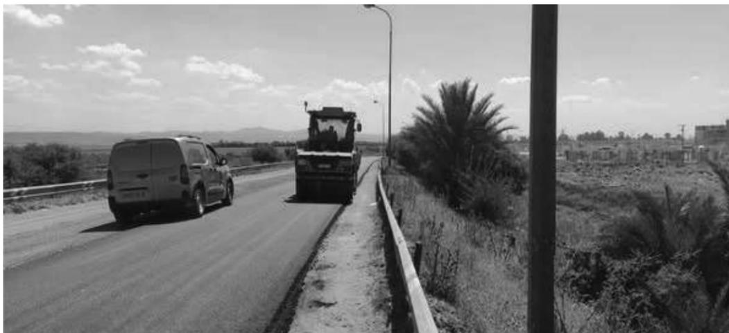
consistent en la pose d'une couche de roulement en béton bitumineux, destinée à renforcer la qualité de la chaussée, à améliorer la sécurité des usagers et
