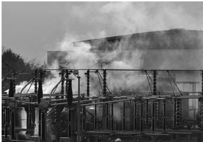
[un composant isolant] du transformateur », probablement « causée par une infiltration », qui a entraîné un court-circuit, détaille l'organisme. « Un taux d'humidité élevé dans l'une des douilles » avait été détecté en 2018, mais « les mesures
