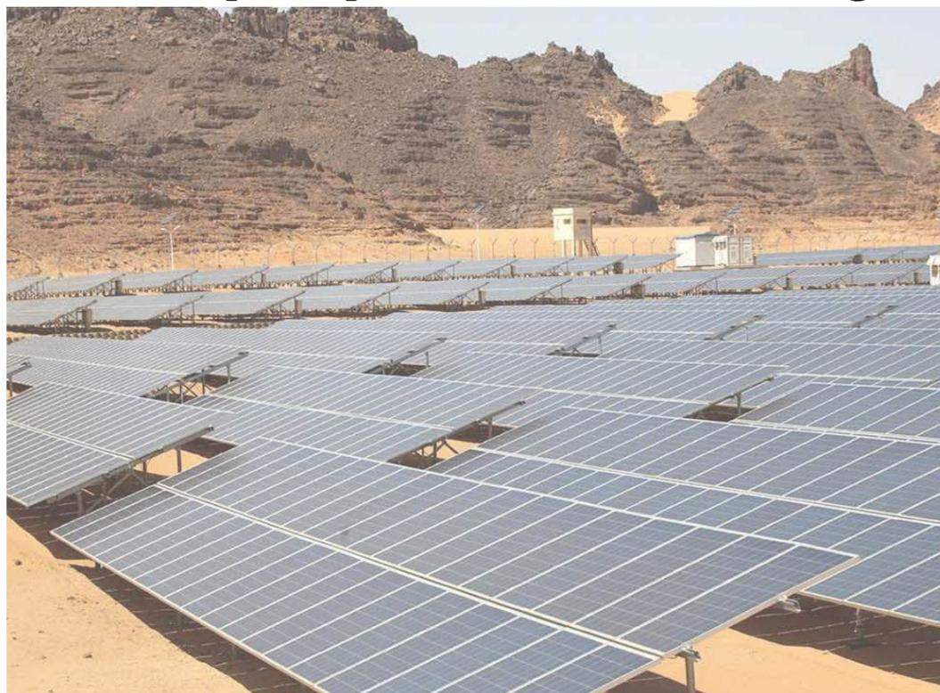
dans les technologies de panneaux déployées. Le site intègre 100 kW de modules en silicium amorphe, 100 kW en tellure de cadmium. Ainsi que 315 kW en panneaux monocristallins et 606 kW en polycristallins. Ces configurations variées ont permis une analyse comparative poussée des performances selon les technologies et les systèmes d'orientation.
